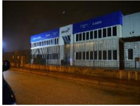
Figura 36 - Edificio in via Panà
