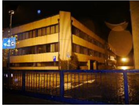
Figura 38 - Edificio in via Panà
