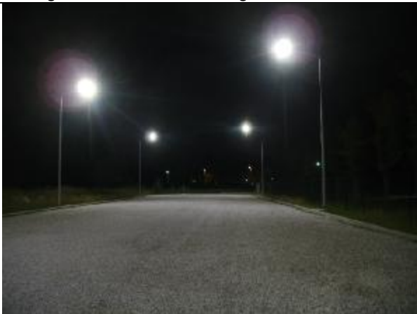
Figura 25 - Ingresso e parcheggio complesso scolastico
