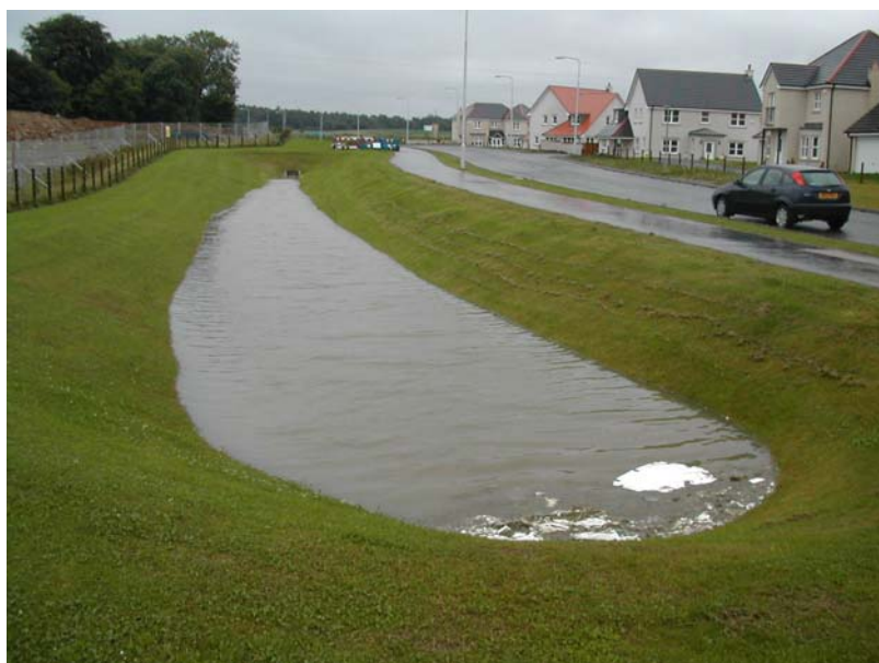
Figura 3. Bacino di detenzione
